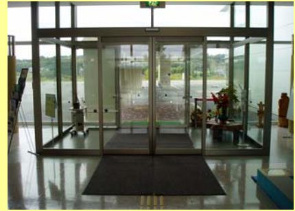
↑補修した風除室
