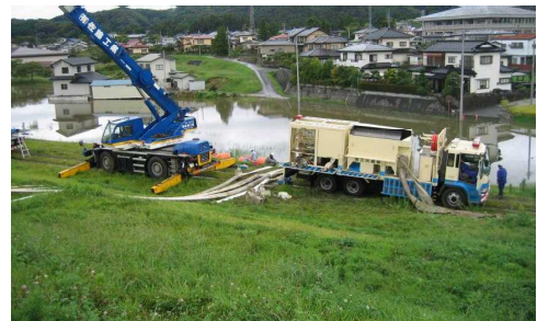
排水ポンプ車による排水活動状況 (平成19年9月洪水・平泉町倉町地区)
