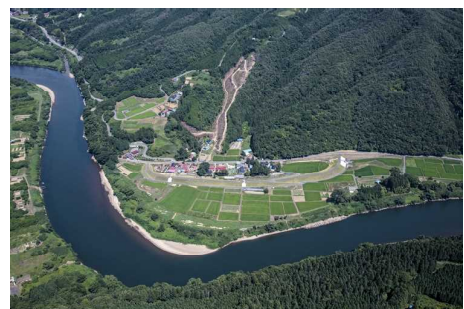
北上川狭隘地区治水対策事業の輪中堤整備状況 (一関市小日形地区)
