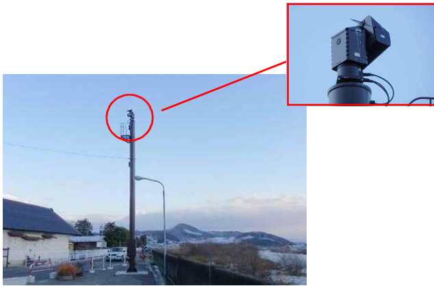
洪水時の状況を把握するCCTVカメラ
