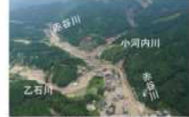
④赤谷川における 土砂・洪水氾濫及び流木による被害 (福岡県朝倉市)
