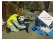
Ku-SAT設置状況(宮古市)
