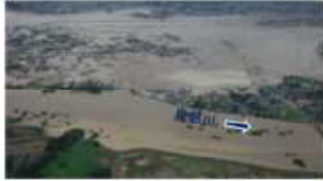
①鬼怒川における浸水被害 (茨城県常総市)
