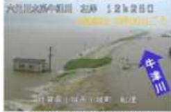
⑨牛津川の浸水被害 (佐賀県小城市)
