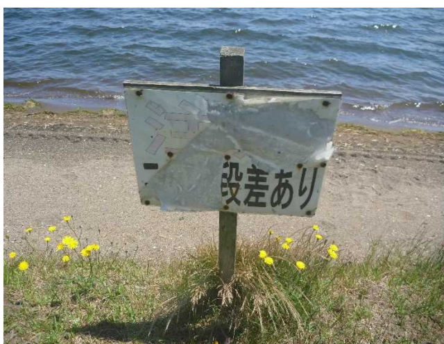
公園内の段差注意喚起看板の腐食
