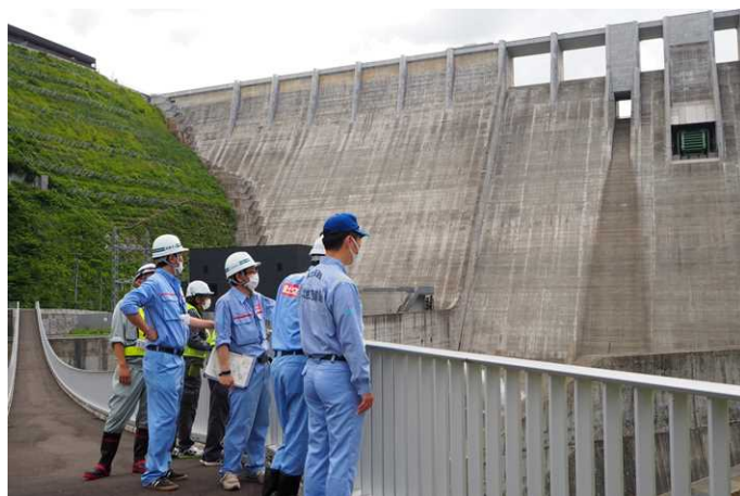
維持工事担当者と点検(白神が故郷橋パーク)
