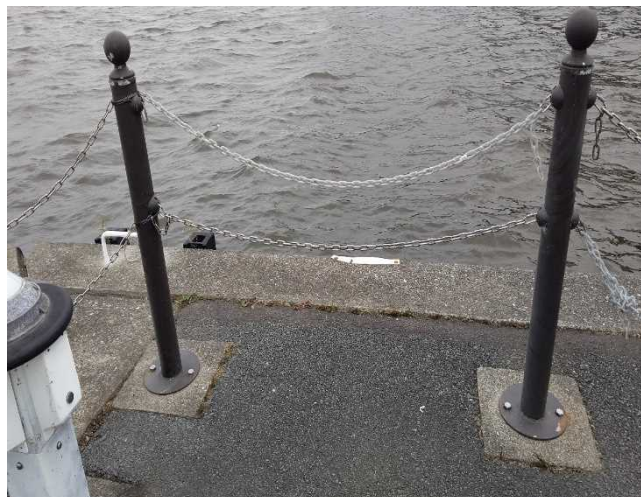
新たにチェーンを設置(措置完了)
