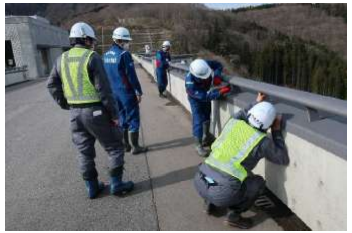
維持工事担当者との点検(津軽ダム堤体天端)
