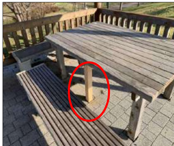
4月15日 修理完了
