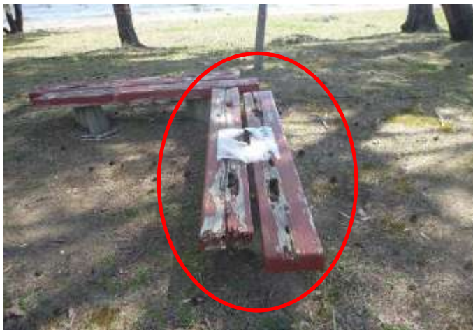
ベンチの損傷
