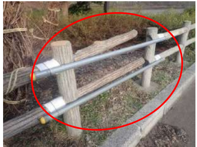
4月16日 単管による応急措置完了
