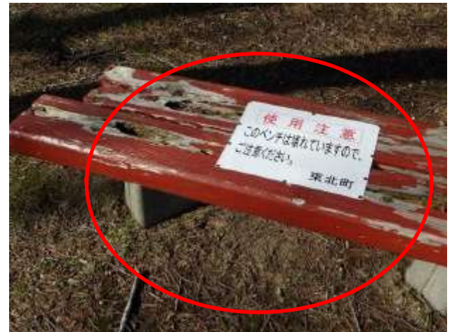
4月20日 貼り紙により注意喚起措置完了
