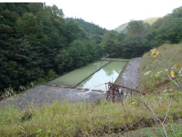
第2、3沈殿池、清澄池
