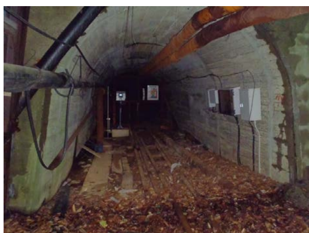
坑道内部の状況
