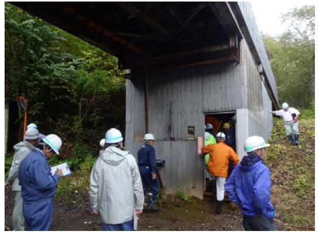
凝集剤タンク室
