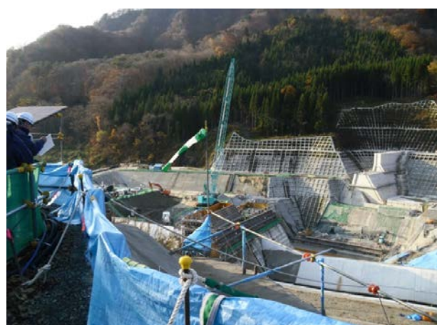
【2号水質保全施設の工事状況】
