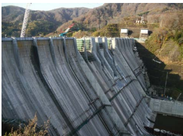
【津軽ダム(下流面より)】
