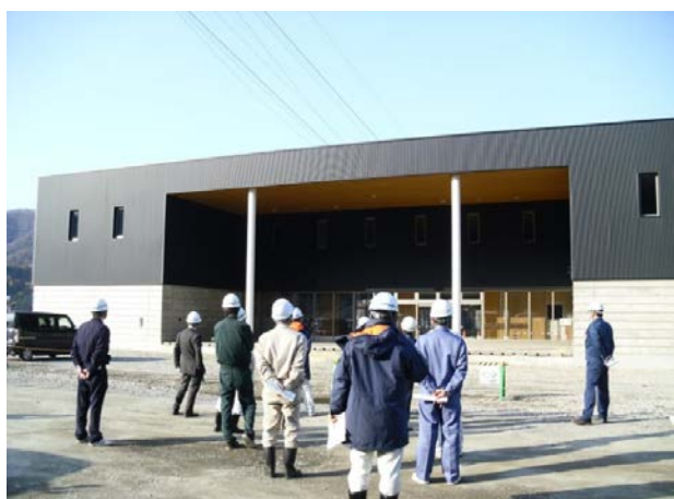
【津軽ダム管理庁舎】
