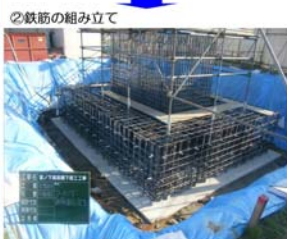
②鉄筋の組み立て
