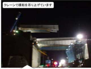
クレーンで橋桁を吊り上げています
