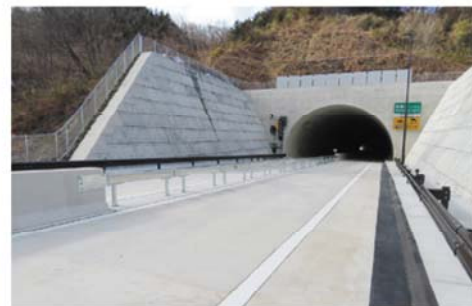
④ 馬館山トンネル
