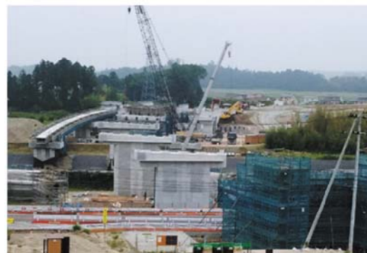
① 荒屋舗大橋
