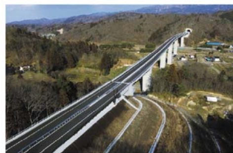
③ 月館高架橋
