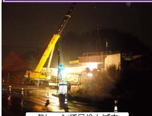
クレーンで吊り上げ中
