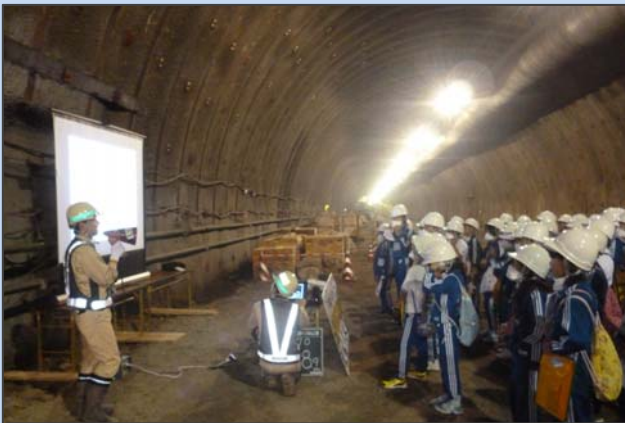
プロジェクターを使いトンネルの造り方を説明中
