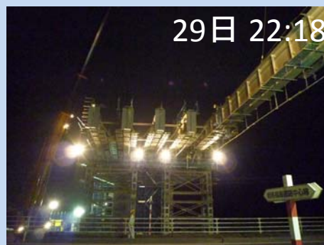
最初の1本目が架設完了
