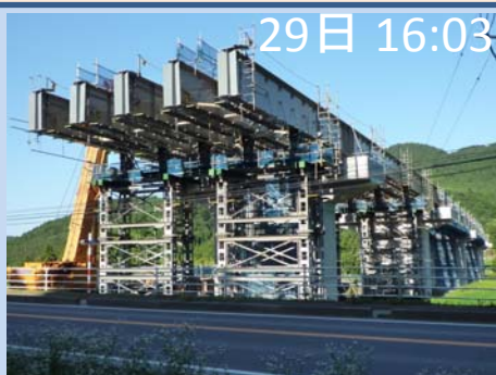
架設前(昼)の状況
