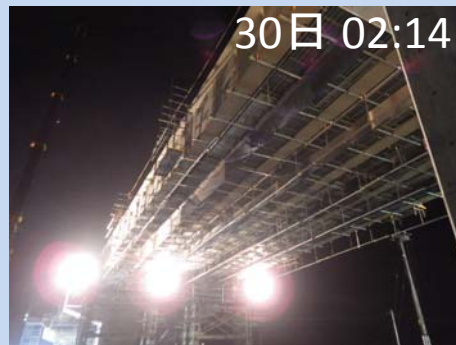
5本全ての桁が架設完了(1日目)
