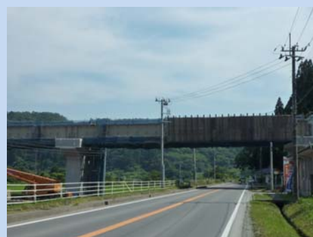
架設後(昼)の状況
