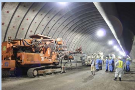
▲トンネル内で施工機械など見学
