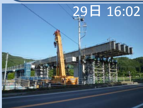
架設前(昼)の状況
