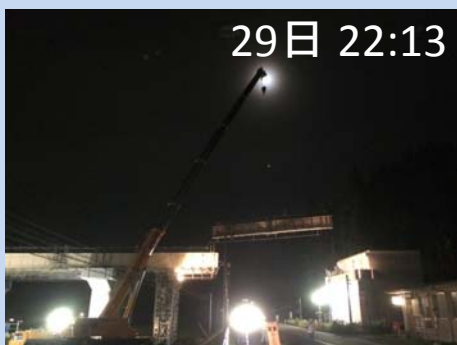
長さ約20mの桁が国道115号上空に
