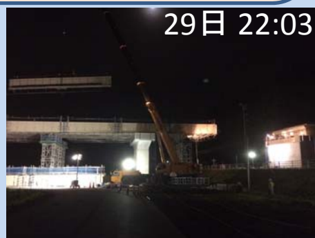
桁架設を開始
