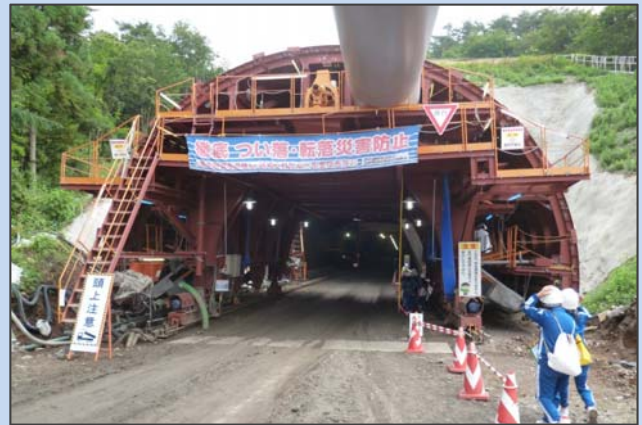
いよいよトンネルの中へ
