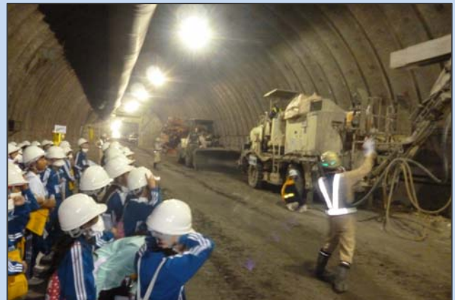
トンネル施工機械の説明
