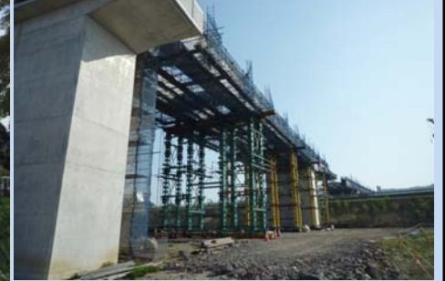
今田高架橋(東側)
