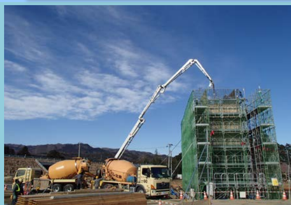
橋脚 柱部コンクリート打設状況
