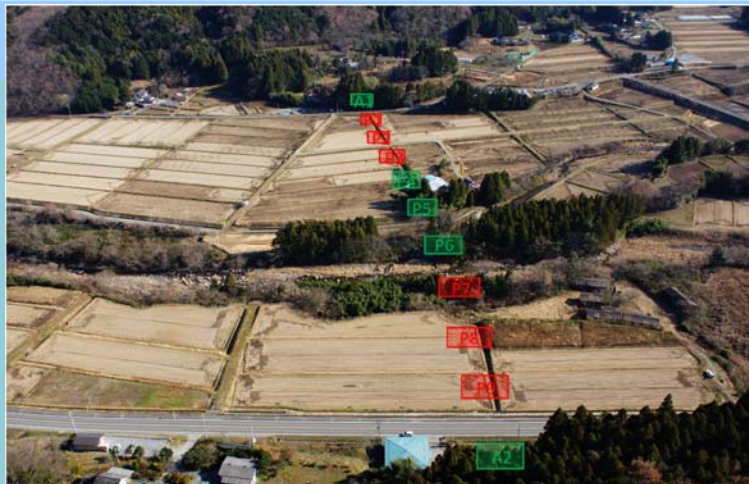
横川高架橋(仮称) 赤枠が今回工事の施工箇所
