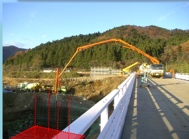
P7橋脚 フーチング(赤着色部)コンクリート打設状況
