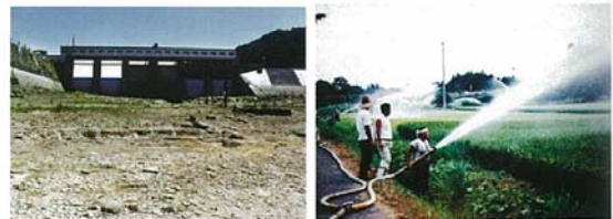
底をつく石淵ダム
