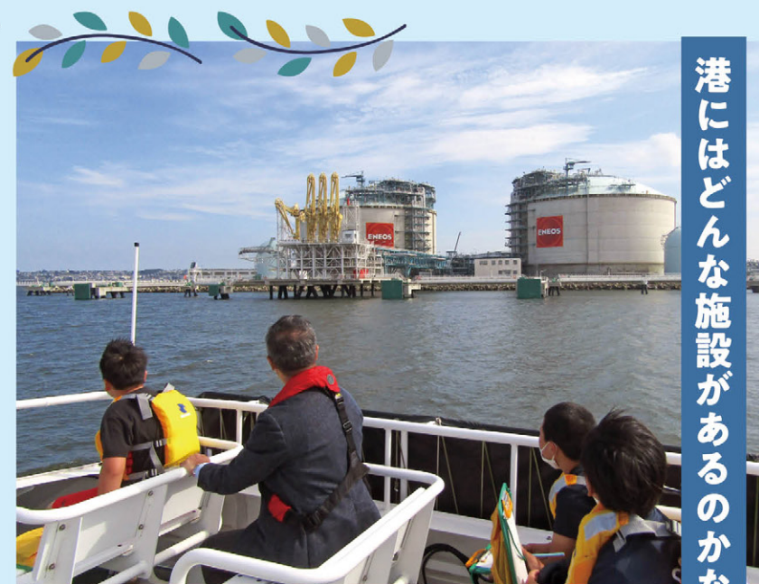
▲LNG(液化天然ガス)を貯蓄する巨大タンク1つで、20万世帯の1年分のガス使用量を貯蔵
