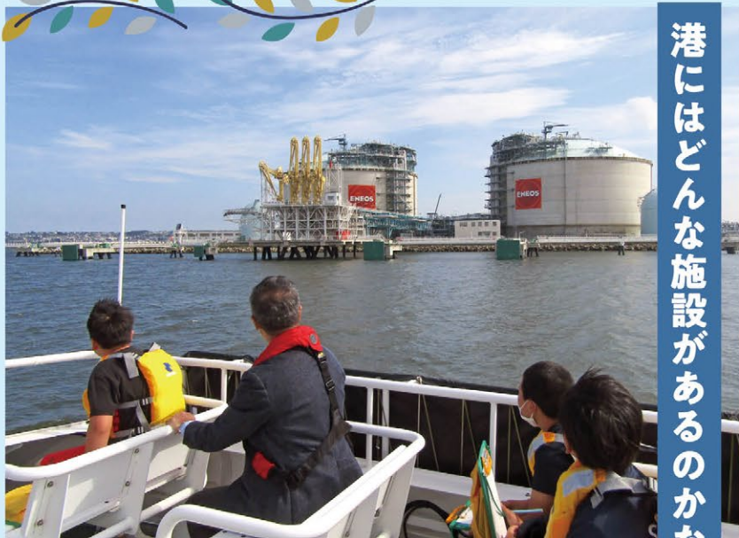
▲LNG(液化天然ガス)を貯蓄する巨大タンク1つで、20万世帯の1年分のガス使用量を貯蔵
