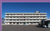
震災遺構 仙台市立荒浜小学校
