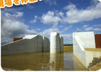
(一関遊水地長島水門新設工事)
