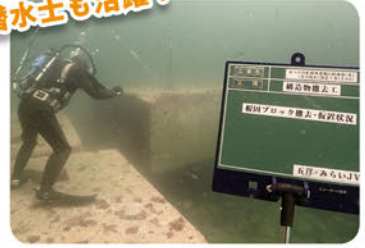
(むつ小川原港外港地区防波堤(東)(災害復旧)築造工事)
