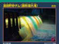
湯田貯砂ダム
