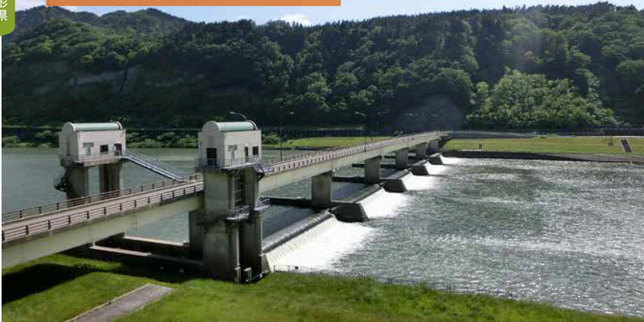
さみだれ大堰
