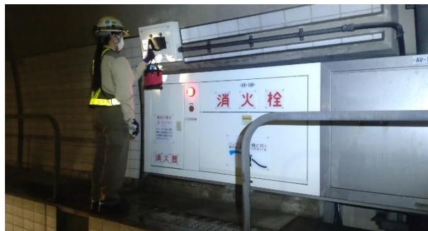
トンネル設備（火災検知器）点検作業
