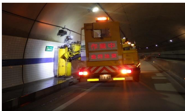
トンネル壁面清掃作業
