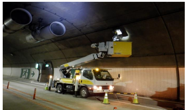
トンネル設備（照明灯）点検作業
