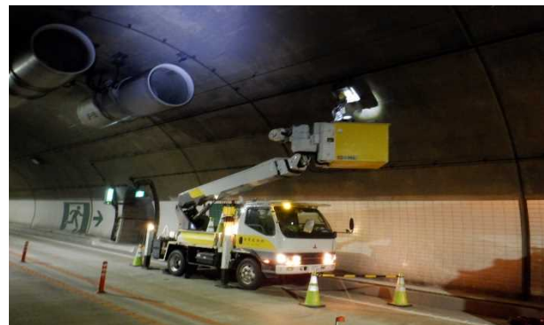
トンネル設備（照明灯）点検作業の様子
