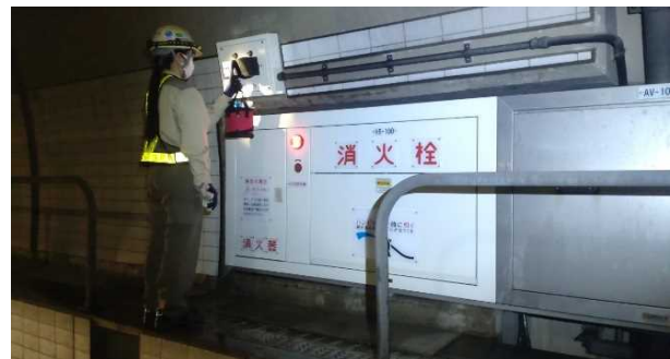
トンネル設備（火災検知器）点検作業の様子
