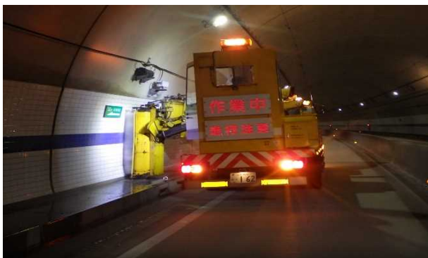
トンネル壁面清掃作業の様子
