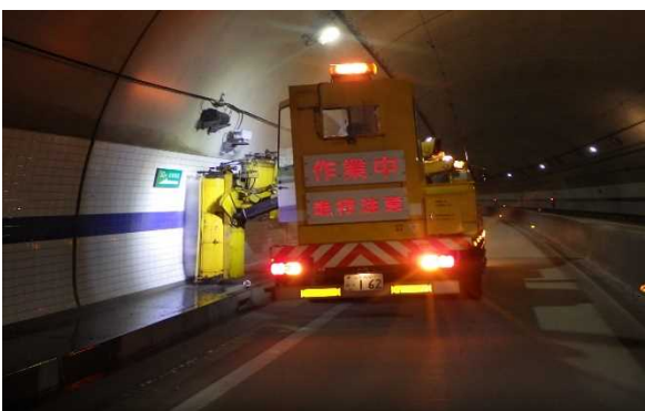
トンネル壁面清掃作業の様子
