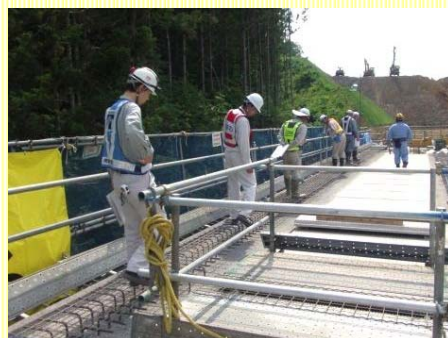
▲彦平橋上部工工事点検の様子
