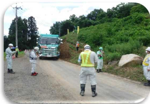
松川地区道路改良工事 受注者：株式会社 日新土建
