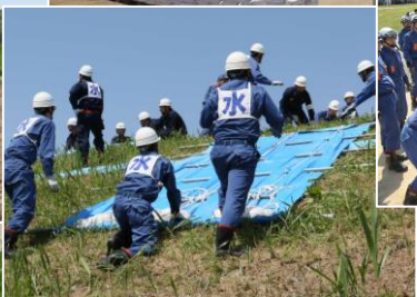
玉川村消防団：シート張工
