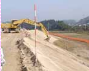
工事現場状況
