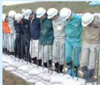
積土のう工法
