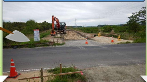
須賀川市浜尾施工中の状況
