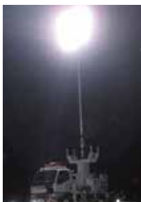
破堤箇所の応急復旧作業
