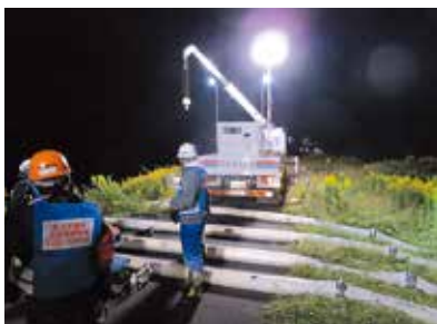
堤防越水箇所の排水作業
