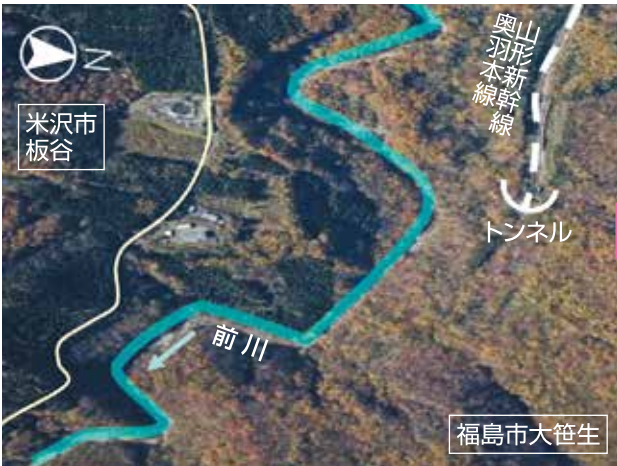
工事前【前川第1砂防堰堤】
