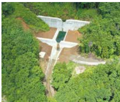
下高湯沢第1砂防堰堤(R4.3完成)
