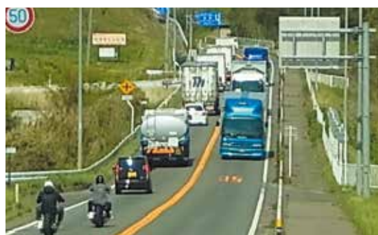
▲付加車線設置付近の状況(整備前)
