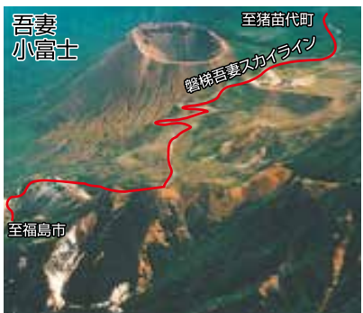
火山ガスで変質した脆弱な斜面
