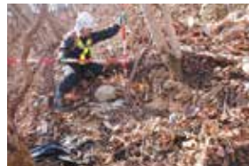
防災(法面)点検
