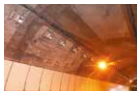
トンネル補修
