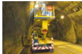
トンネル点検
