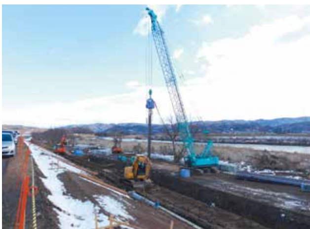
鋼矢板施工状況
