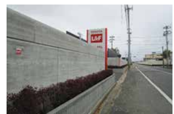
【郡山市】民間企業における止水壁の設置
