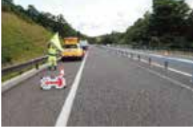
道路巡回の実施(1回/2日～2回/1日)
