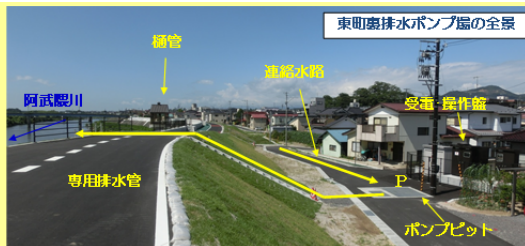
完成した東町裏排水ポンプ場
