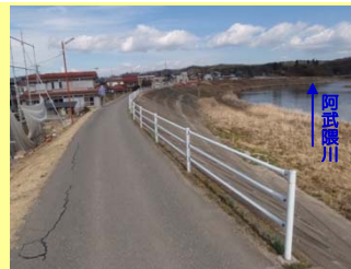
着工前の河川堤防
