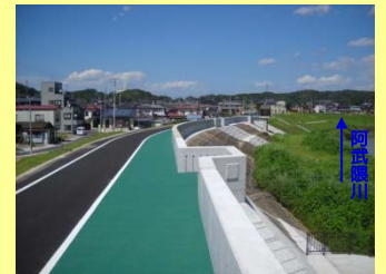
完成した河川堤防
