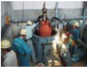
排水機場内の点検
