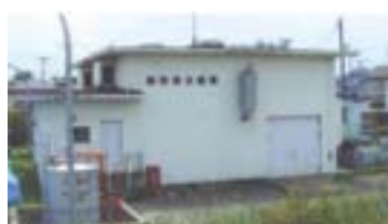
南町排水機場(福島市)
