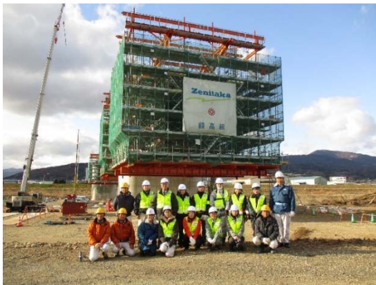
▲安全パトロールを実施していただいた参加者の方々並びに現場の全景写真
