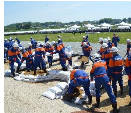
水防団による工法 （月の輪工）
