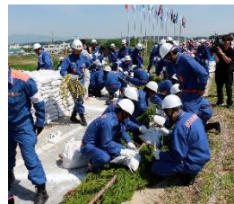
水防団による工法 （木流し工）
