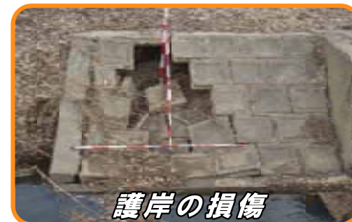
車両による堤防損傷
