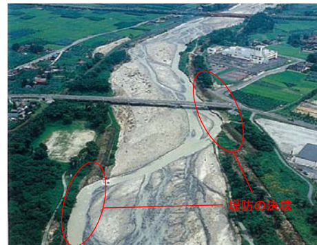
写真5-3 低水路の蛇行による堤防決壊 平成元年8月洪水 支川荒川
