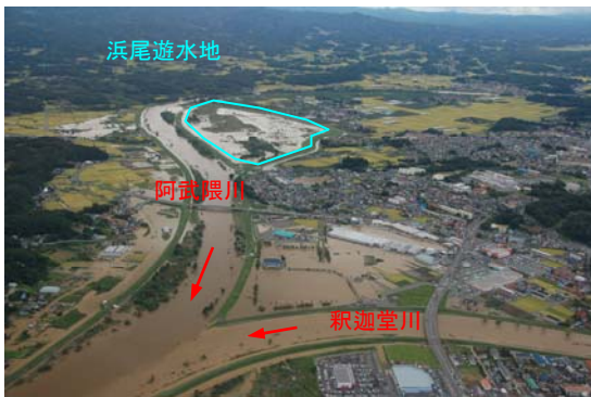
写真 1 - 3 平成 23 年 9 月洪水の浸水状況 須賀川市釈迦堂川合流点付近
