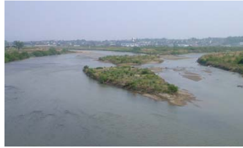
写真5-2 釈迦堂川合流点の土砂堆積状況
