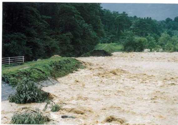
日の倉橋上流右岸の破堤状況/福島県福島市/9月16日/（福島工業試験所）
