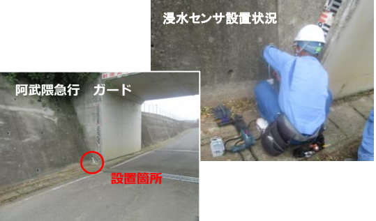
◀▲浸水常襲箇所に浸水センサ設置
