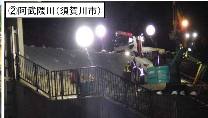
24時間体制での緊急復旧作業の様子(R1.11.8完了)
