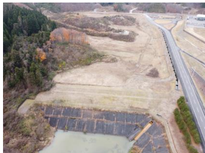
掘削土搬入前（令和3年11月）
