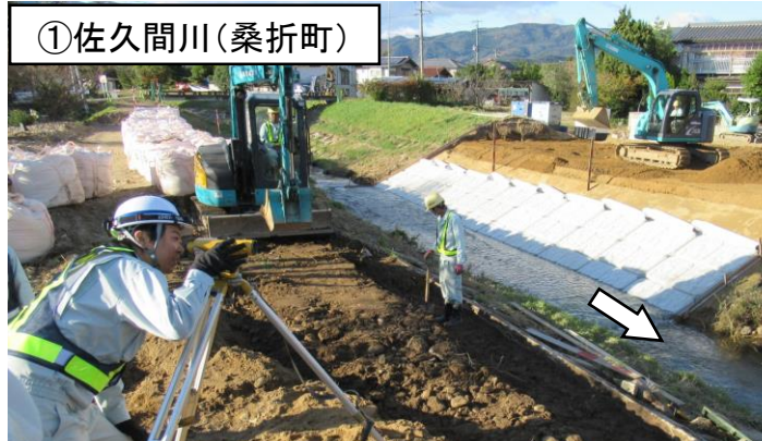
権限代行区間での緊急復旧作業の様子(R1.11.7完了)
