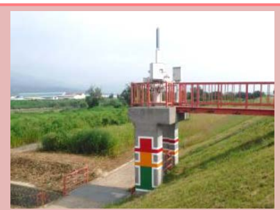
箱崎樋管水位表示
