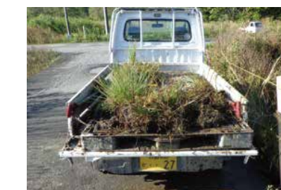
貴重植物の移植作業
