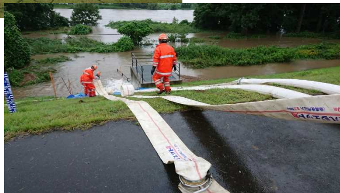
排水作業の事例
