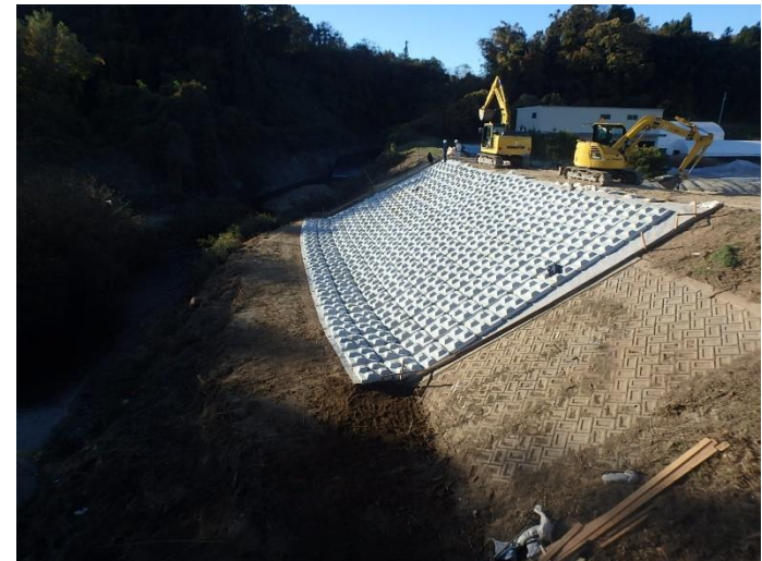
2019. 11. 15 15時00分 ブロック設置完了(上流側)
