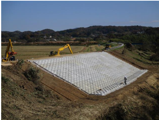
2019. 11. 13 8時30分 ブロック設置完了(下流側)
