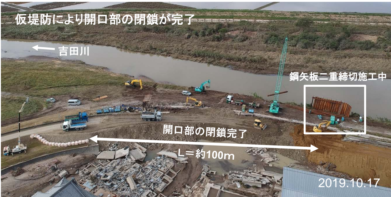
鋼矢板二重締切施工開始
