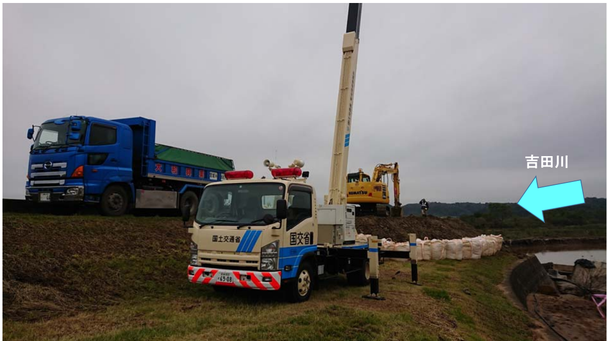
荒締切施工状況
