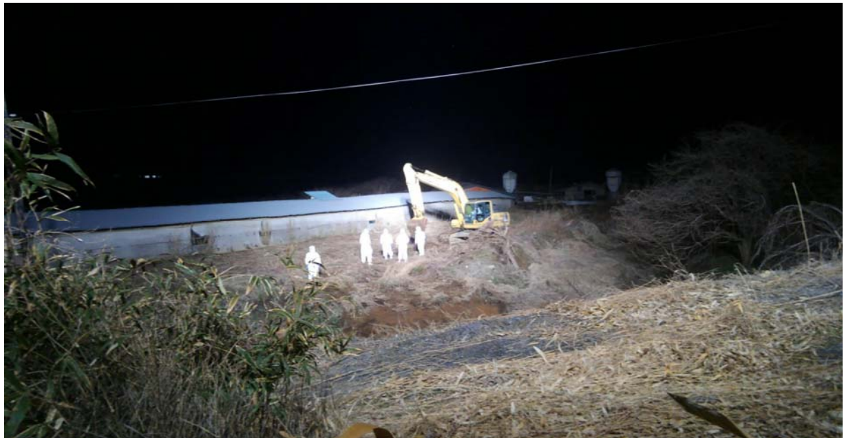
現地を照明車で照らした状況(宮城県栗原市)
