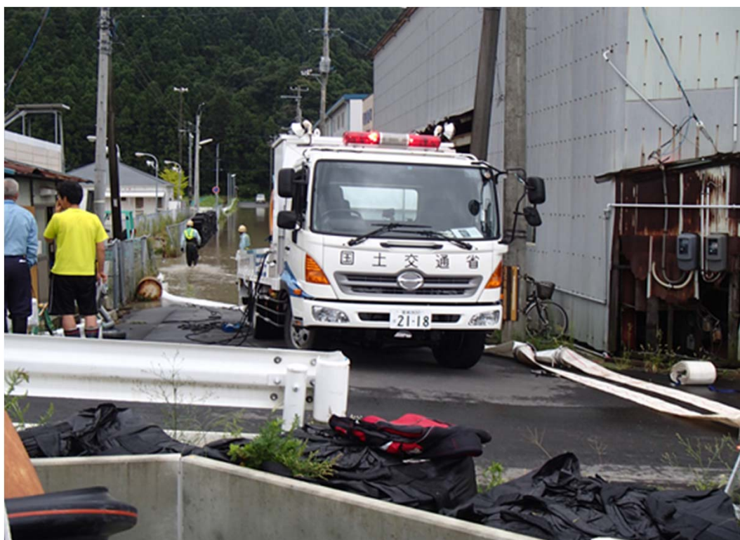
不動沢第1ポンプ場（石巻市不動町地内）【排水ポンプ車30m 3 /分】
