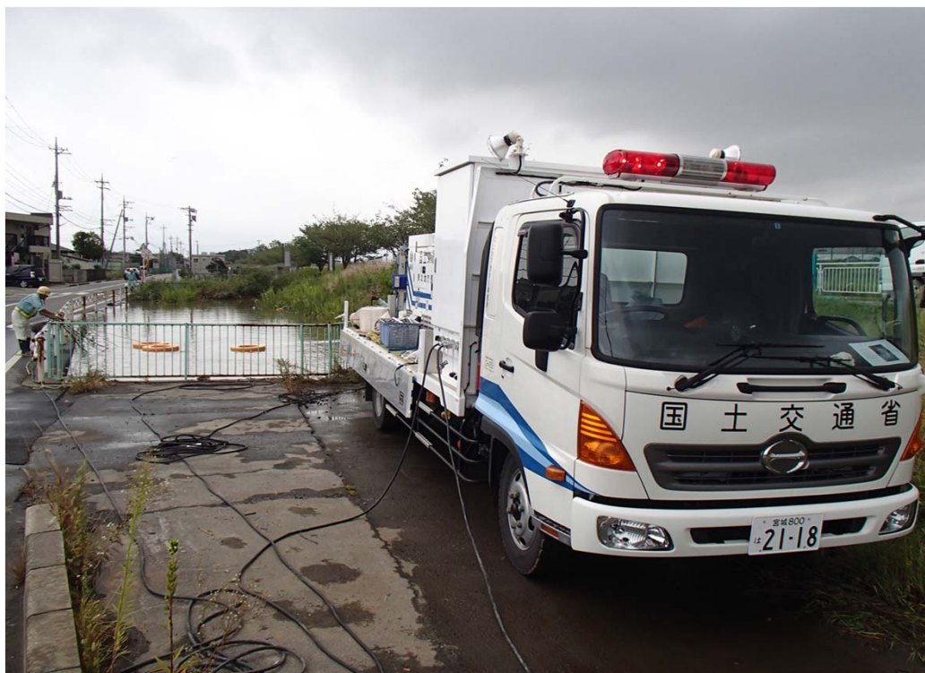
横堤ポンプ場（石巻市貞山地内）【排水ポンプ車30m 3 /分】
