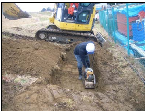
(土中壁施工状況)
