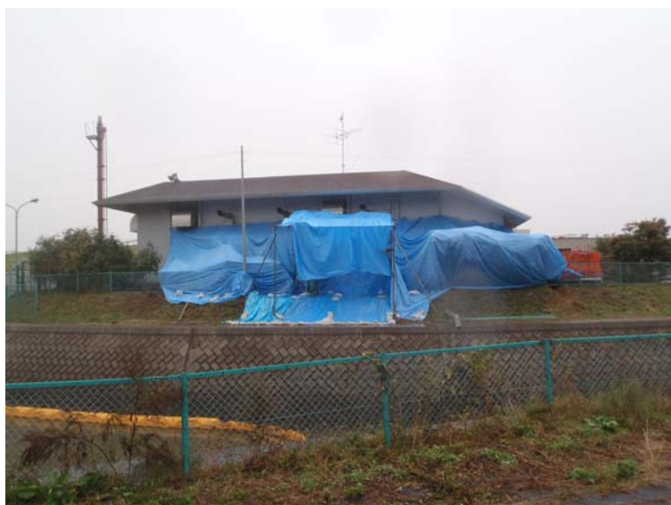
対応箇所全景
