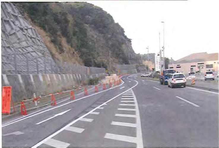
▲撤去後の状況(いわき市四倉町)
