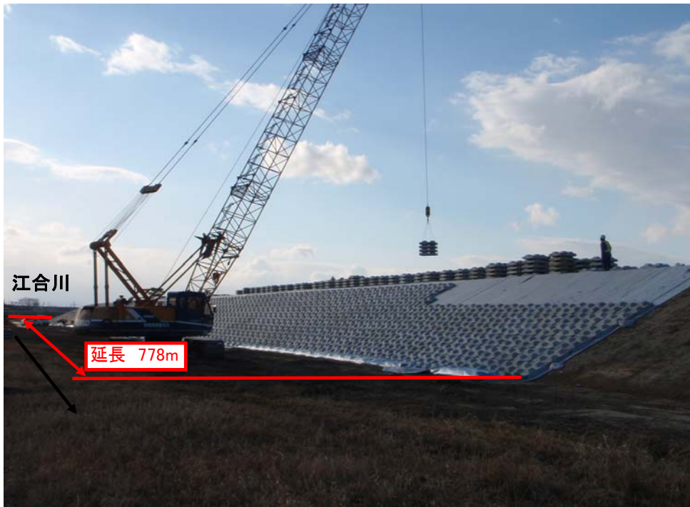
4月3日16時頃 緊急復旧工事でコンクリートブロック設置中
