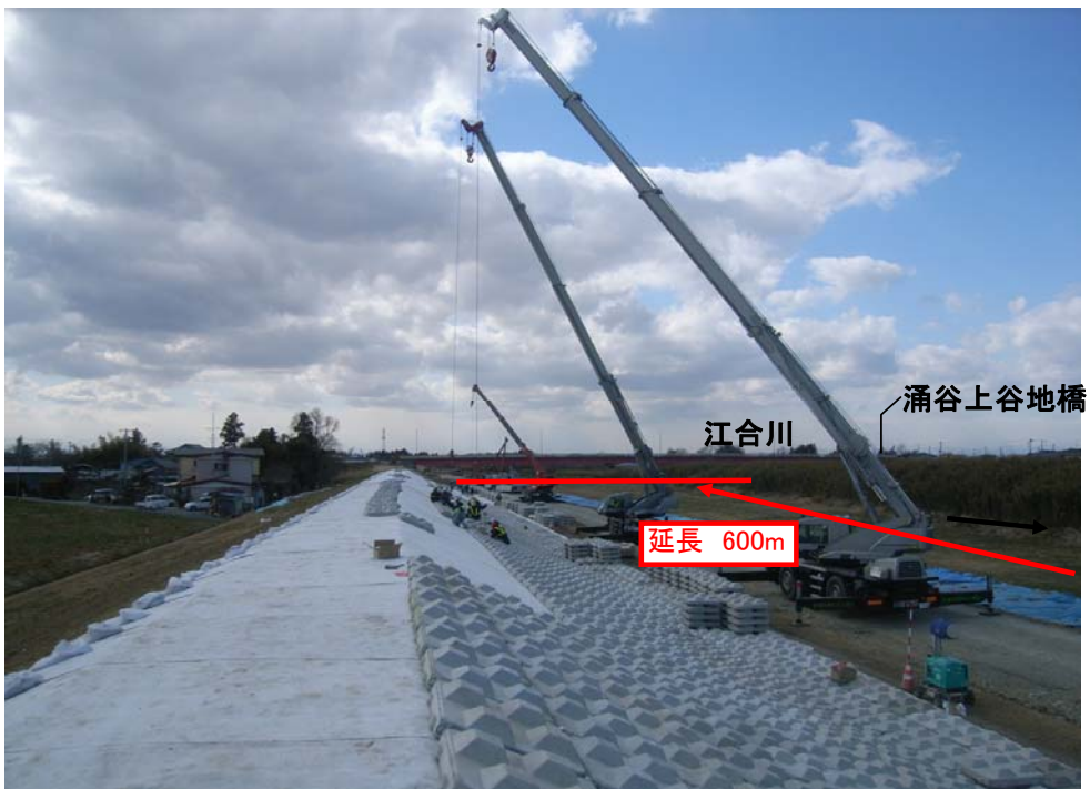
4月3日15時頃 緊急復旧工事でコンクリートブロック設置中
