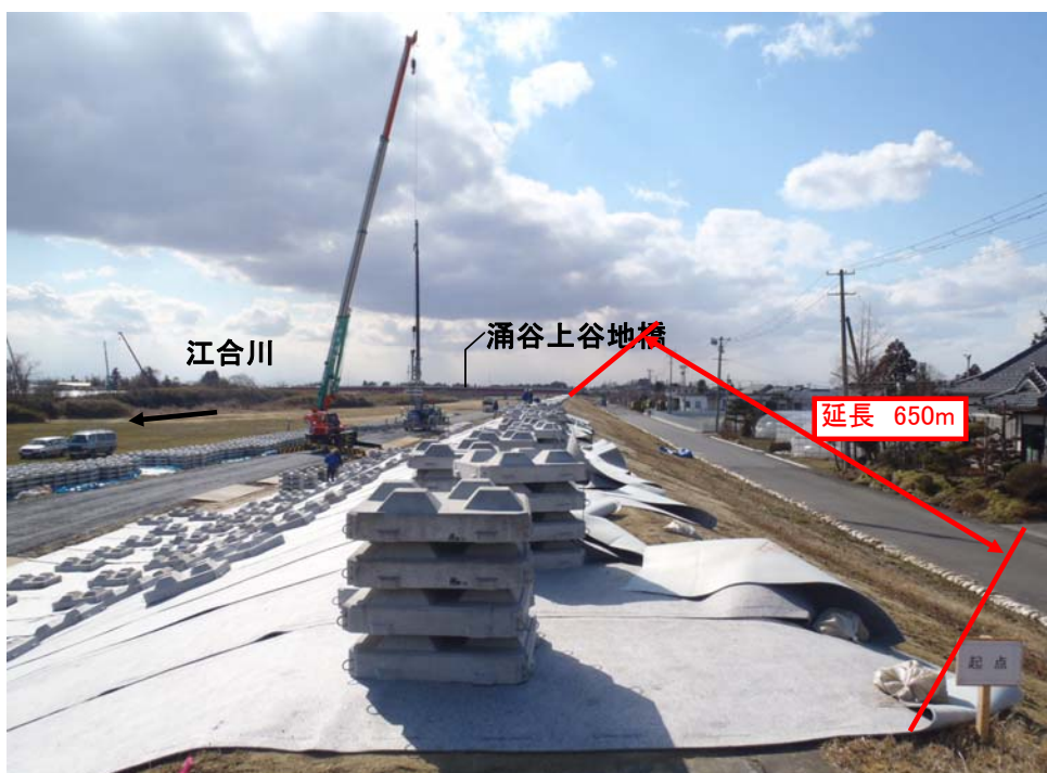
4月3日15時頃 緊急復旧工事で遮水シート張り実施中
