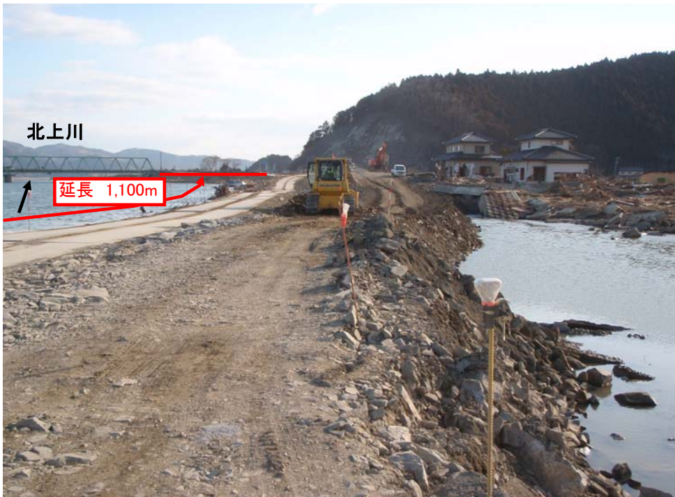
4月3日7時頃 緊急復旧工事で仮設道路拡幅中
