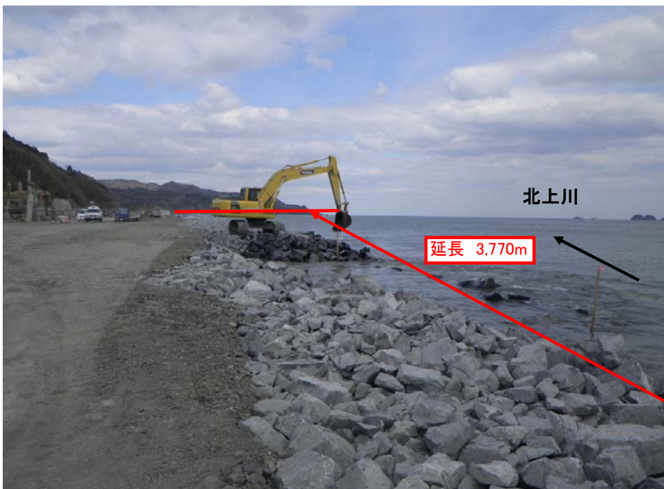
4月3日14時頃 緊急復旧工事で捨石工実施中
