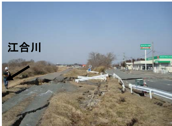
3月11日堤防被害状況 堤防亀裂・沈下
