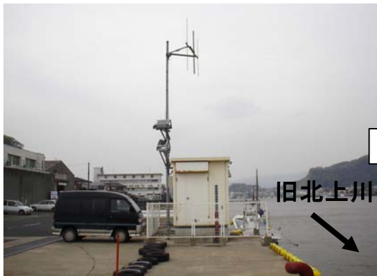
被災前の門脇水位観測所 (石巻市門脇)
