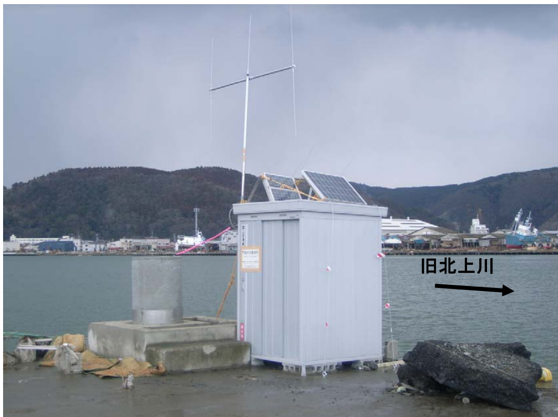
3月26日 仮復旧し観測を開始した門脇水位観測所
