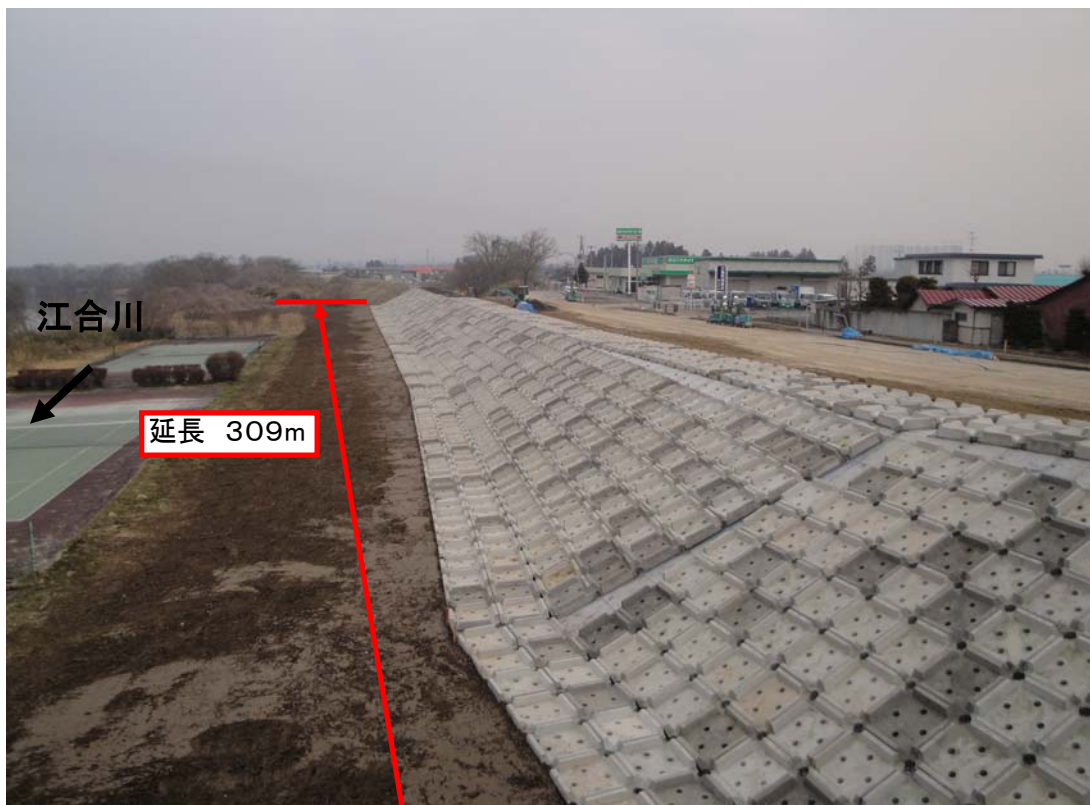
3月31日6時頃 コンクリートブロック張り状況
