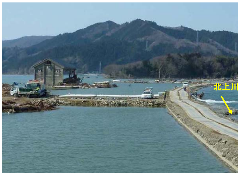
3月29日 9時30分頃 排水ポンプ車による北上川への排水状況 (150m 3 /m 1台)
