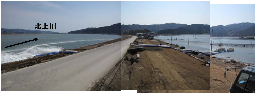
3月29日9時30分頃 排水ポンプ車による北上川への排水状況 (45m 3 /m 2台)
